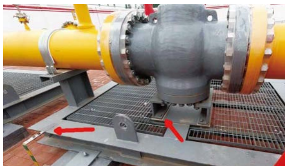
图6 某输气管道干线阀室接地情况
