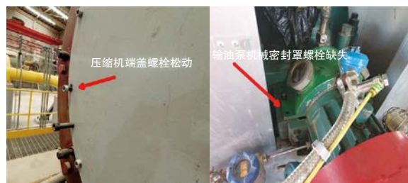
图7 检查中发现的设备维护管理问题现状
