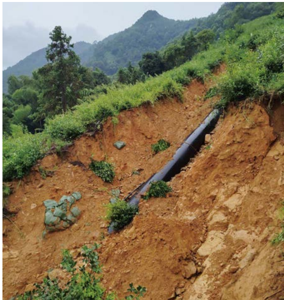
图1 坡面水毁及管道露管情况
