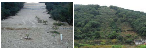
图5 手工撒播修复植被前（左）后（右）效果对比
