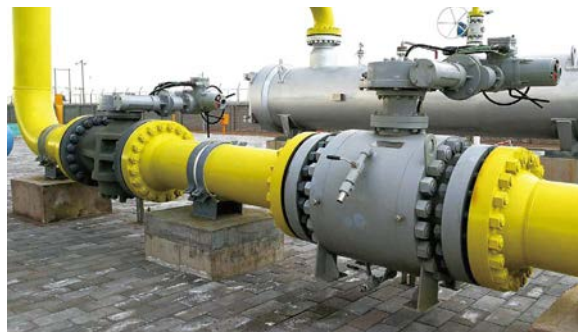
图1 某站场管道阀门支撑实况
