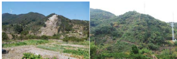
图2 厚层基材喷播施工前（左）后（右）效果对比
