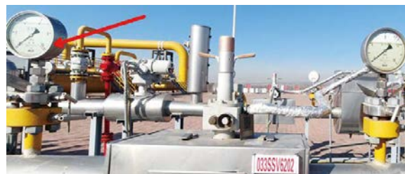
图8 某输气站场压力表量程不合适的情况
